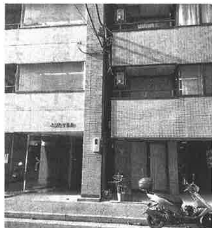
隣との隙間が極端に狭いビルが並ぶ
