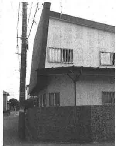
境界ぎりぎりに設けられた屋根
