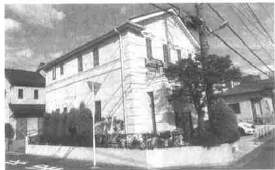
植栽で敷地内の電柱を覆っている
