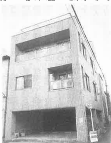
1階部分にあるビルトインガレージ
