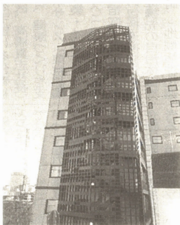
避難階段と空調の室外機が隠されている外観
